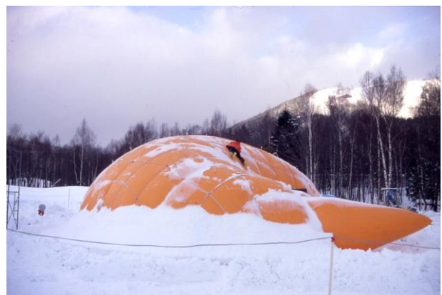
(d) Non-circular membrane bag + Grid pattern [7]
