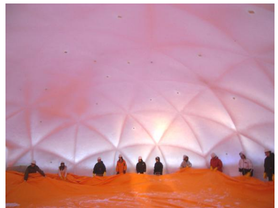
(d) Removing membrane
