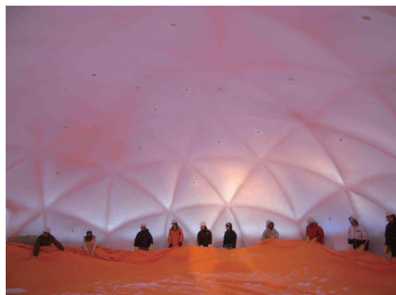
(d) Removing membrane
