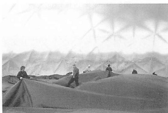
写真4 膜の除去作業。
