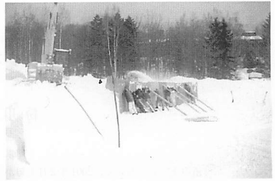
写真 1 雪氷基礎リングの施工。
