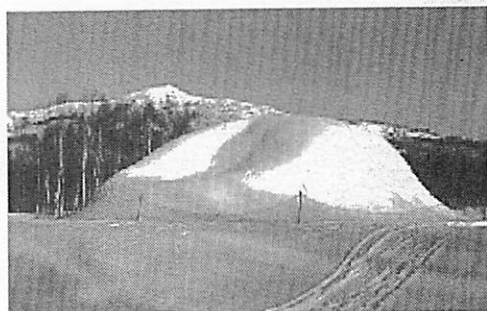
写真9 崩壊前の大変形
