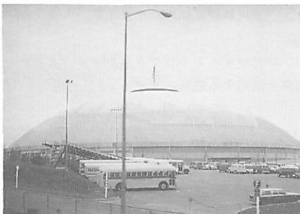
図-1 タコマドーム (世界最大の木造ドーム) 外観
