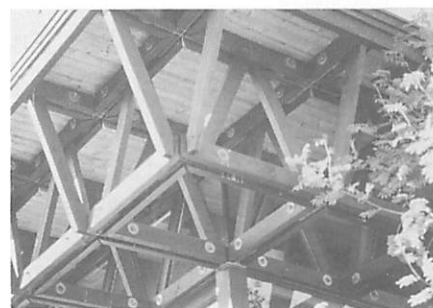
図-7 非ボールジョイントの例その2
