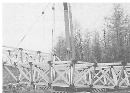
図-23 吊り上げ移動
